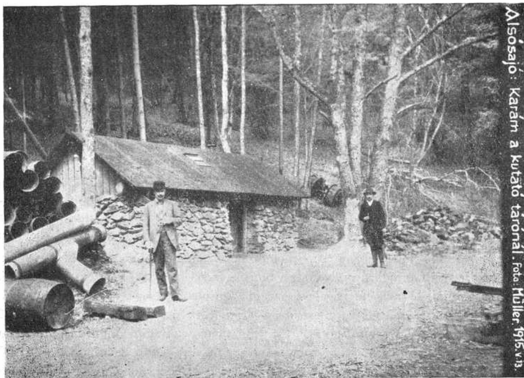
Obr. 6. Krám z Nižnej Slanej z r. 1915. Strecha je už pokrytá tērovým papierom a dymový otvor je nahradený stabilným zaskleným okienkom. Foto A. Kostková.
